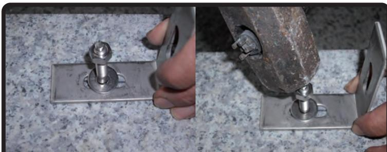
パワーアンカーを軽く穴に差し込み石頭等で頭部分を軽く数回打ち込んで下さい。
