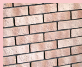
空目地(目地を入れない施工)
