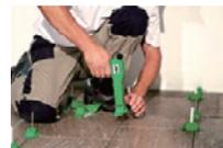
⑤ 接着剤硬化後、MLTガンを使用しストラップとキャップを外します。
