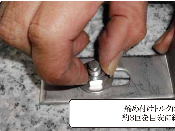
打ち込み後ナットを3回転回した状態
