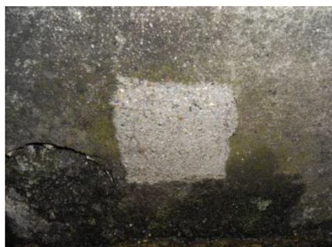
・強力な噴射力により文字の中の苔・汚れ等をピンポイントで洗浄できる。
