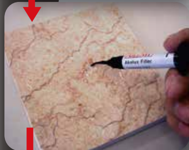
アケルックス透明リキッドで 破損箇所を埋めます
