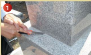
1 浸透性剥離剤(ボンドリムーバー・リムーバーZ)をコーキング部に吹き付け表面を少し柔らかくします。その後、コーキング部をカッターで切り取ります。
