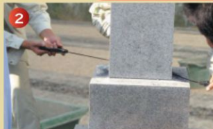
2 目地部分にクサビやパールを差し込み目地部を少し広げます。目地にコーキングのこを入れて接着部分を切っていきます。
