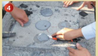
4 解体後は浸透性剥離剤(ボンドリムーバー・リムーバーZ)を使用するとより効果的に接着剤部分の取り除きができます。
